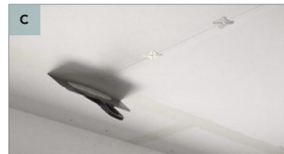
Spackla skarvar, tejsa och spackla igen: Använd önskat verktyg för att fylla skarven. Upprepa tills skarven är ordentligt fylld.
