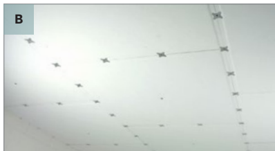
Montage av undertaksskivor: Rockfon Mono Acoustic-skivorna skruvas i bärverket. Direktmontage (skruvad/limmad) på lufttätt underlag är också möjligt.
