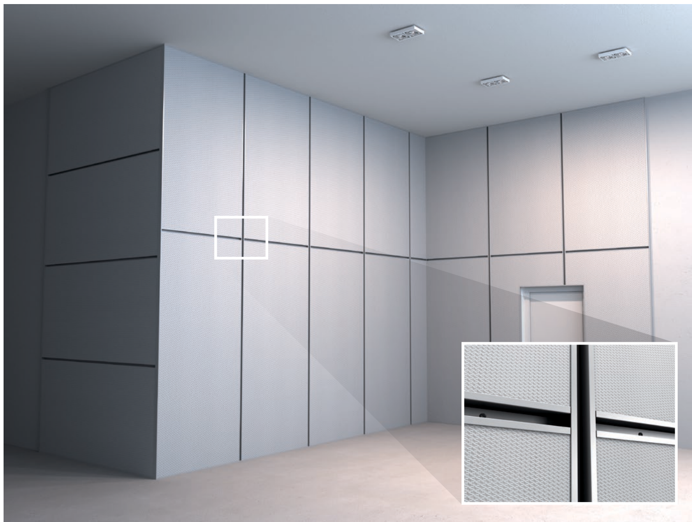
3.1 Samtliga Rockfon VertiQ väggabsorbenter och HAT-profiler har monterats.
